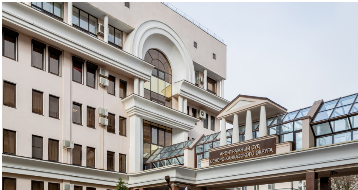
Стеклянная галерея, соединяющая 2 здания суда.
