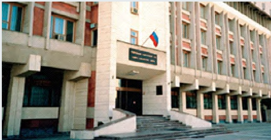
Здание суда округа до реконструкции.
